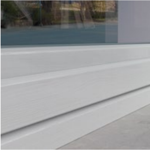
Détail de la fenêtre externe. Version cadre avec butée en aluminium ou avec butée en bois.
